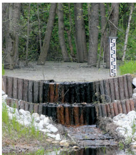
Fot. 56. Spowalnianie odpływu wody – zastawki na rowach drenujących (fot. zagan.zielonagora.lasy.gov.pl)
