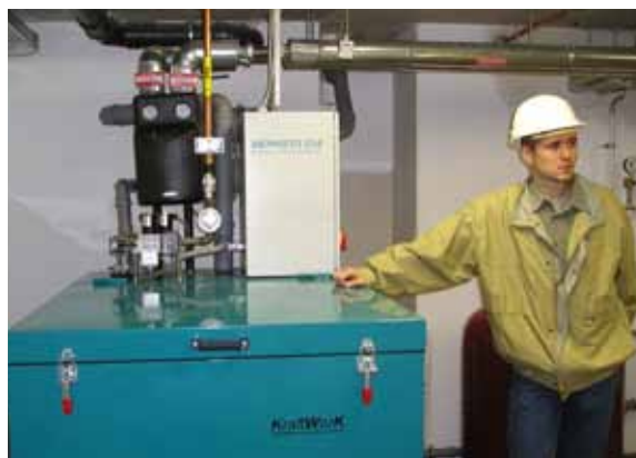
Rysunek 10.2 Przykład bloku kogeneracyjnego (na bazie silnika tłokowego) o mocy cieplnej 30 kW, sprawności produkcji ciepła 68,6%, mocy elektrycznej 14 kW i sprawności produkcji energii elektrycznej 31,5% pracującego na potrzeby osiedla wielorodzinnych budynków pasywnych
