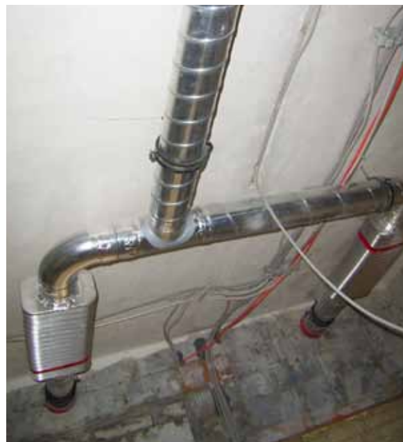
Rysunek 9.6 Indywidualny system wentylacji nawiewno-wywiewnej z odzyskiem ciepła. Widoczne po lewej: rekuperator z przyłączeniami po prawej: system kanałów z tłumikami
