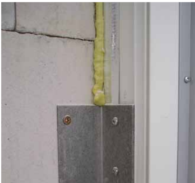
Rysunek 7.5 Przykładowy montaż okna w warstwie izolacji, widoczne taśmy uszczelniające, kotwy kątowe i precyzyjne docięcie izolacji do ramy
