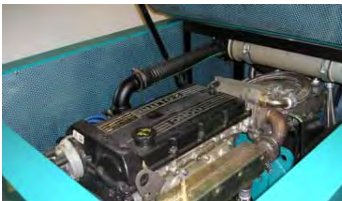
Rysunek 10.2 Przykład bloku kogeneracyjnego (na bazie silnika tłokowego) o mocy cieplnej 30 kW, sprawności produkcji ciepła 68,6%, mocy elektrycznej 14 kW i sprawności produkcji energii elektrycznej 31,5% pracującego na potrzeby osiedla wielorodzinnych budynków pasywnych
