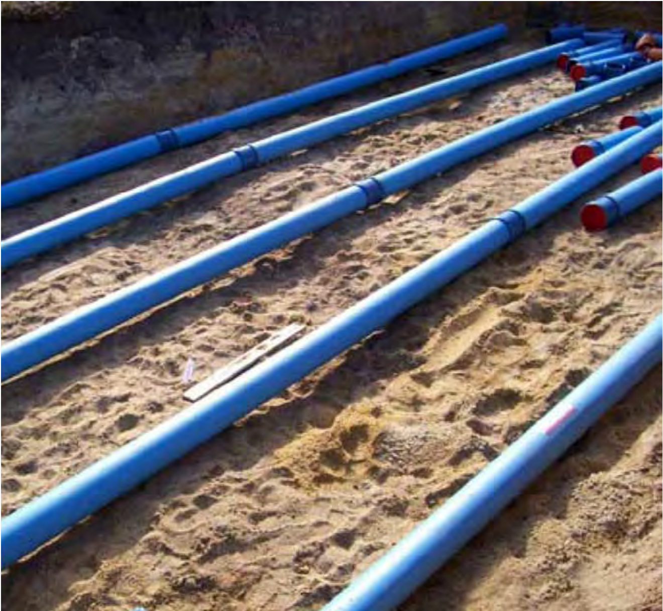
Rysunek 17.7 Wykonanie gruntowego wymiennika ciepła, źródło: Lipińscy Domy
