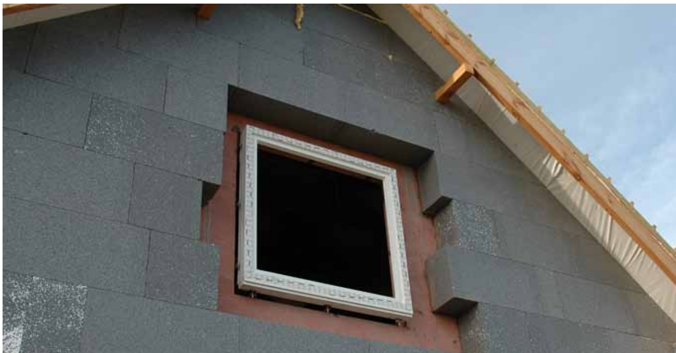
Rysunek 17.5 Montaż okien, źródło: Lipińscy Domy
