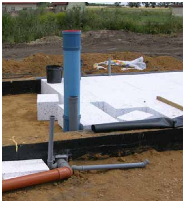
Rysunek 17.3 Wykonanie podłogi na gruncie z widocznymi pustakami cokołowymi i izolacją, źródło: Lipińscy Domy
