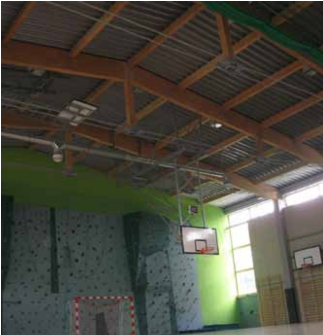
Rysunek 17.11 Hala pasywna w Słomnikach, widoczny system wentylacji mechanicznej, źródło: www.slomniki.pl
