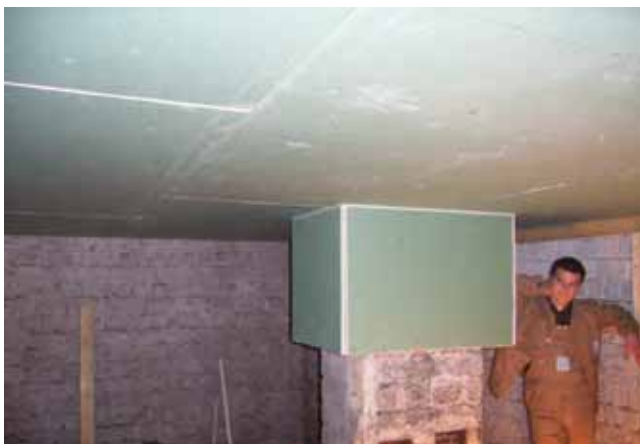
Rysunek 5.8 Docieplenie stropu nad nieogrzewaną piwnicą. Widoczny ruszt drewniany i izolacja pionowa nachodząca na ściany wewnętrzne oraz kominy ograniczają mostki cieplne
