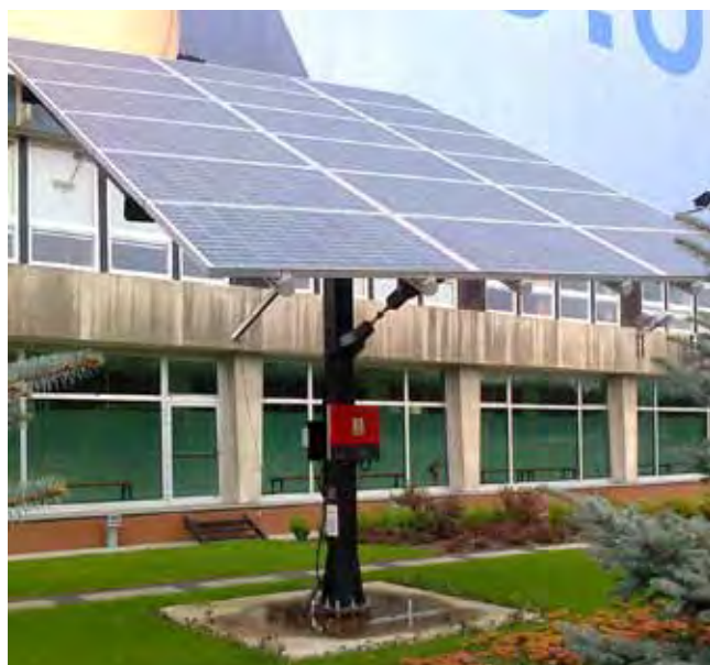
Rysunek 14.6 Instalacja PV, po lewej jednoosiowy system śledzenia położenia słońca, po prawej nieruchoma konstrukcja wolnostojąca
