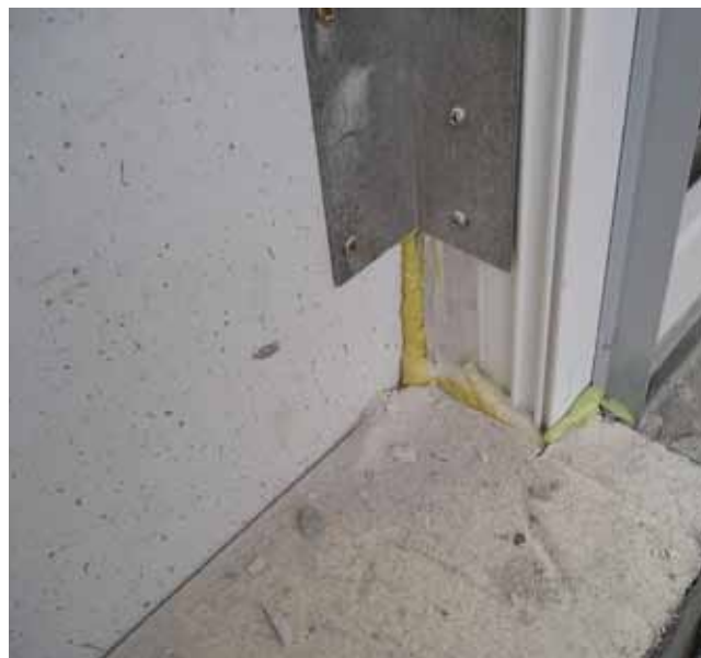
Rysunek 7.5 Przykładowy montaż okna w warstwie izolacji, widoczne taśmy uszczelniające, kotwy kątowe i precyzyjne docięcie izolacji do ramy
