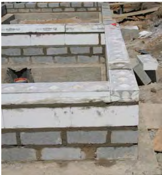
Rysunek 17.3 Wykonanie podłogi na gruncie z widocznymi pustakami cokołowymi i izolacją, źródło: Lipińscy Domy
