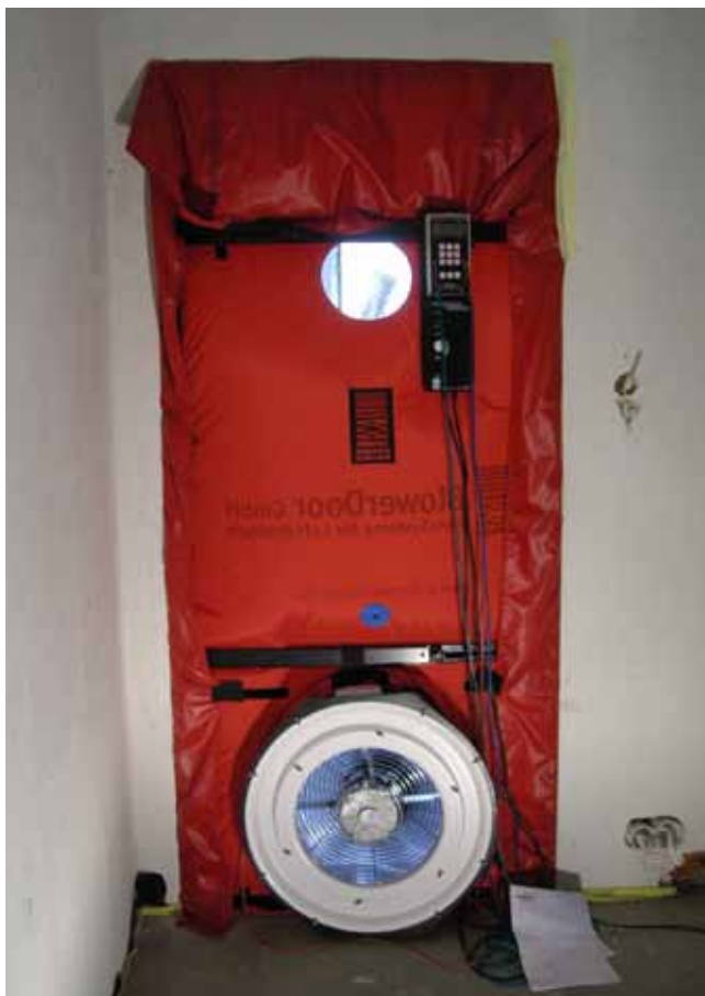
Rysunek 8.11 Test szczelności z wykorzystaniem drzwi nawiewnych
