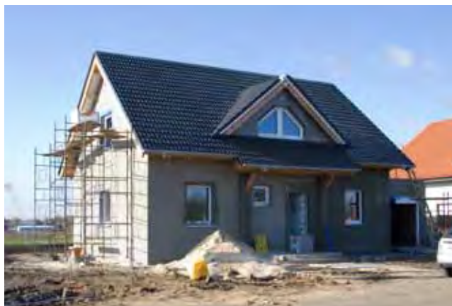
Rysunek 17.2 Montaż prefabrykatów z keramzytobetonu i ocieplanie ścian zewnętrznych, źródło: Lipińscy Domy
