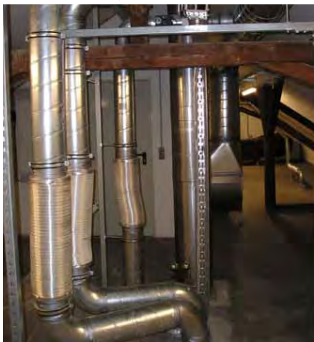
Rysunek 9.5 Centralny system wentylacji nawiewno-wywiewnej. Widoczne po lewej: tłumiki oraz przepustnice regulacji indywidualnej, po prawej: centrala wentylacyjna
