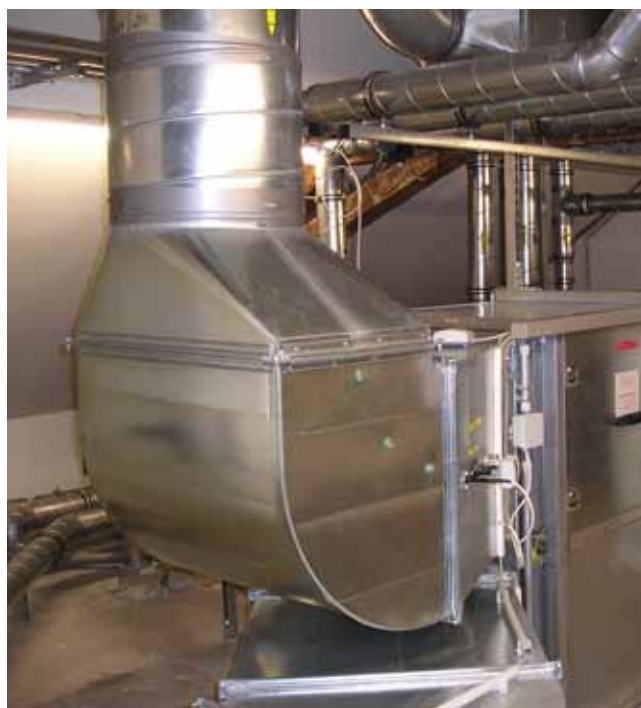
Rysunek 9.5 Centralny system wentylacji nawiewno-wywiewnej. Widoczne po lewej: tłumiki oraz przepustnice regulacji indywidualnej, po prawej: centrala wentylacyjna
