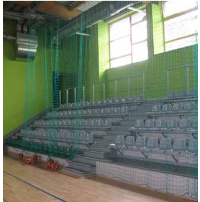
Rysunek 17.11 Hala pasywna w Słomnikach, widoczny system wentylacji mechanicznej, źródło: www.slomniki.pl
