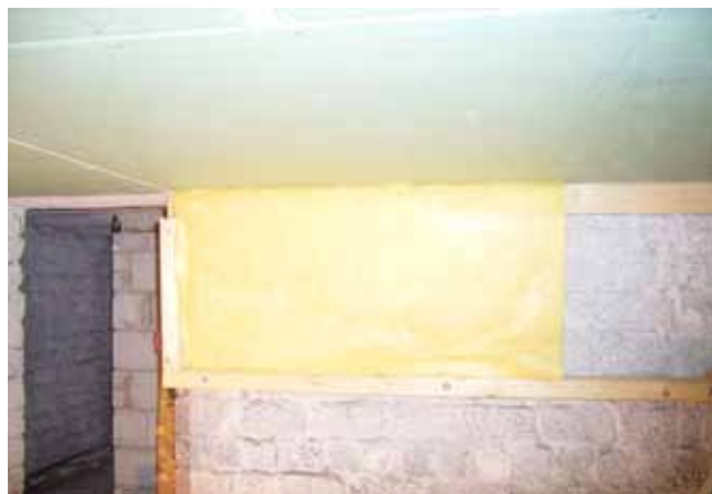
Rysunek 5.8 Docieplenie stropu nad nieogrzewaną piwnicą. Widoczny ruszt drewniany i izolacja pionowa nachodząca na ściany wewnętrzne oraz kominy ograniczają mostki cieplne
