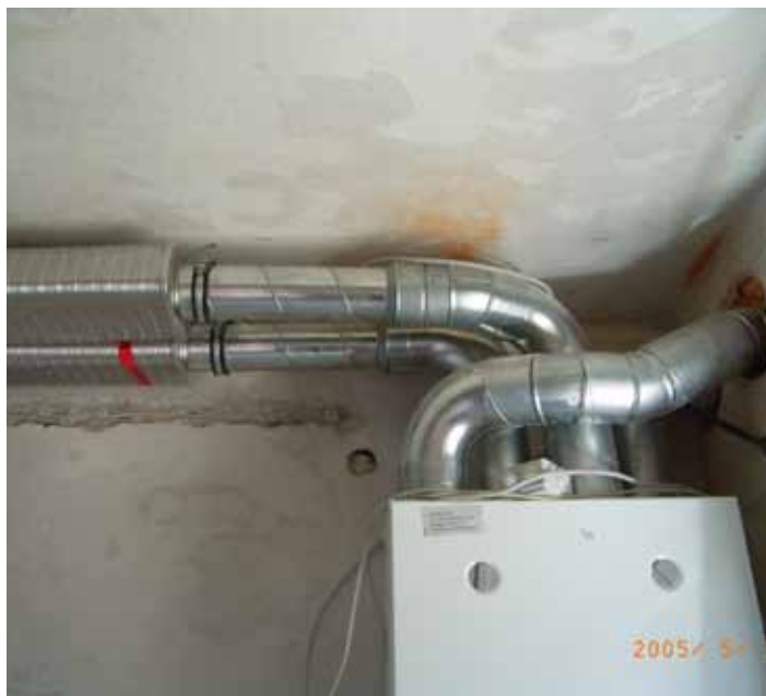
Rysunek 9.6 Indywidualny system wentylacji nawiewno-wywiewnej z odzyskiem ciepła. Widoczne po lewej: rekuperator z przyłączeniami po prawej: system kanałów z tłumikami
