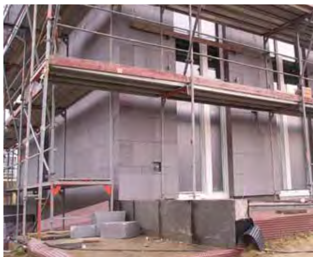
Rysunek 5.5 Ściany zewnętrzne ocieplone 30 cm szarego styropianu – izolacja tylko klejona bez kołkowania
