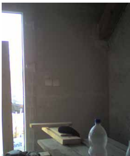
Rysunek 8.10 Wykrywanie nieszczelności – połączenie testu szczelności w podciśnieniu z badaniem termowizyjnym. Nieszczelności – przy włącznikach elektrycznych i dookoła drzwi balkonowych
